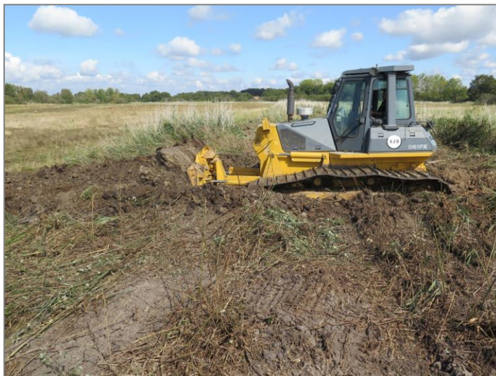
Photo n°5. Régalage des andains de roseaux en queue de l'étang des Fougères.
